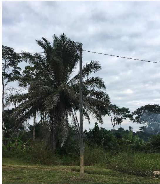
Ilustración 3: Poste de distribución de SEGESA
